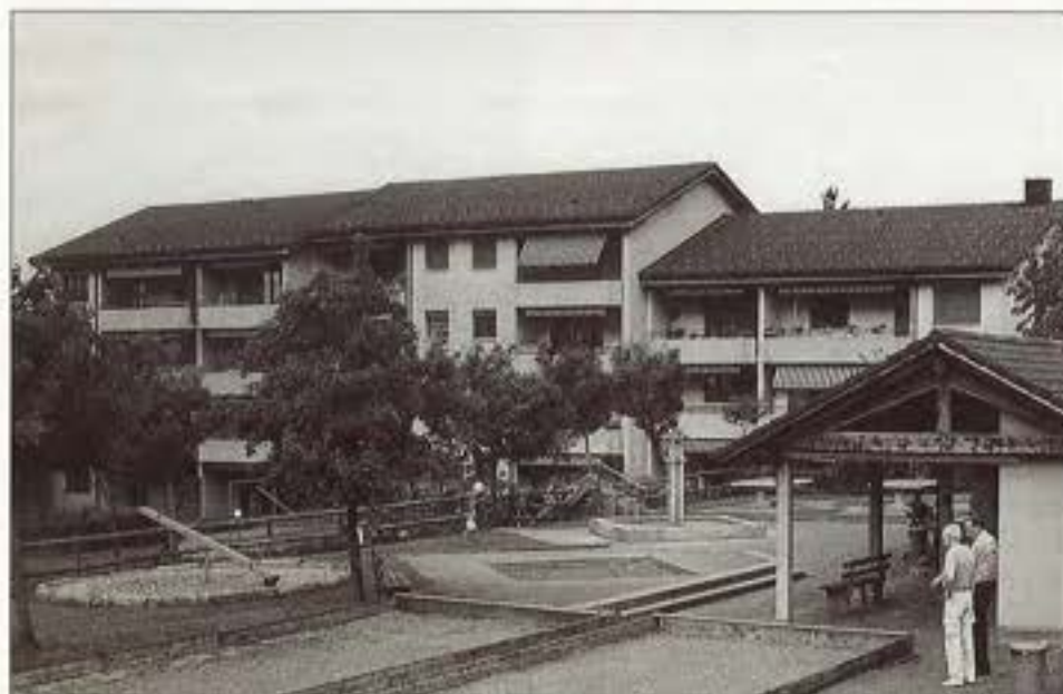
Alle drei Wohnblocks in der Überbauung «Bitzi» der Genossame Schillingsrüti in Altendorf werden mit Holzschnitzeln aus den eigenen Wäldungen beheizt. In den Sommermonaten übernehmen 3 Luft-Wasser-Wärmepumpen und 3 Erdregister-Wärmepumpen die Wärmeherzeugung.
