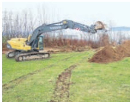
Spatenstich – der Bagger beginnt mit den Aushubarbeiten.
