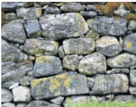
Alter Mauerabschnitt in gutem Zustand, der nicht saniert werden muss.
