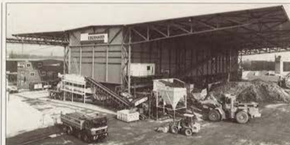
Durch Bodenwäsche kann 90% des Bleis aus dem Erdmaterial herausgeholt und der Wiederverwertung zugeführt werden.
