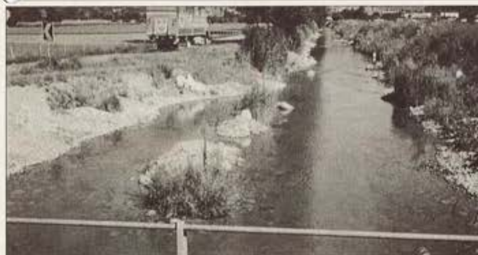
Hier der Machbarkeitsbeweis aus dem Kanton Uri: Die Renaturierung des Giessen mit Trockensteinmauern, Magerwiesenstreifen, Ruderalstandorten, Fischunterständen, natürlichen Uferbefestigungen, Inseln mit Altwasserzonen – ein neuer artenreicher Lebensraum ist wieder entstanden!
