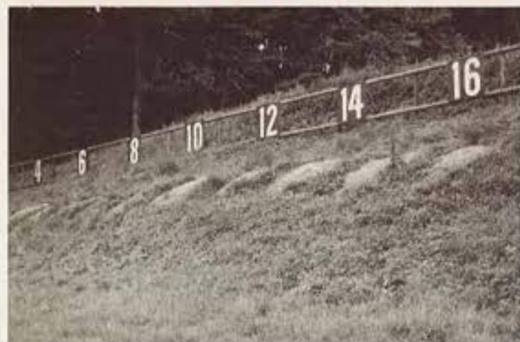
Tonnenweise liegt das giftige Schwermetall in den Erdwällen hinter den Scheiben und stellt damit eine hochkonzentrierte Altlast dar.
