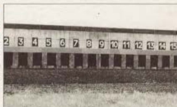
Bei Neuanlagen schliessen künstliche Kugelfangkästen eine Bleibelastung fast zu 100 Prozent aus.
