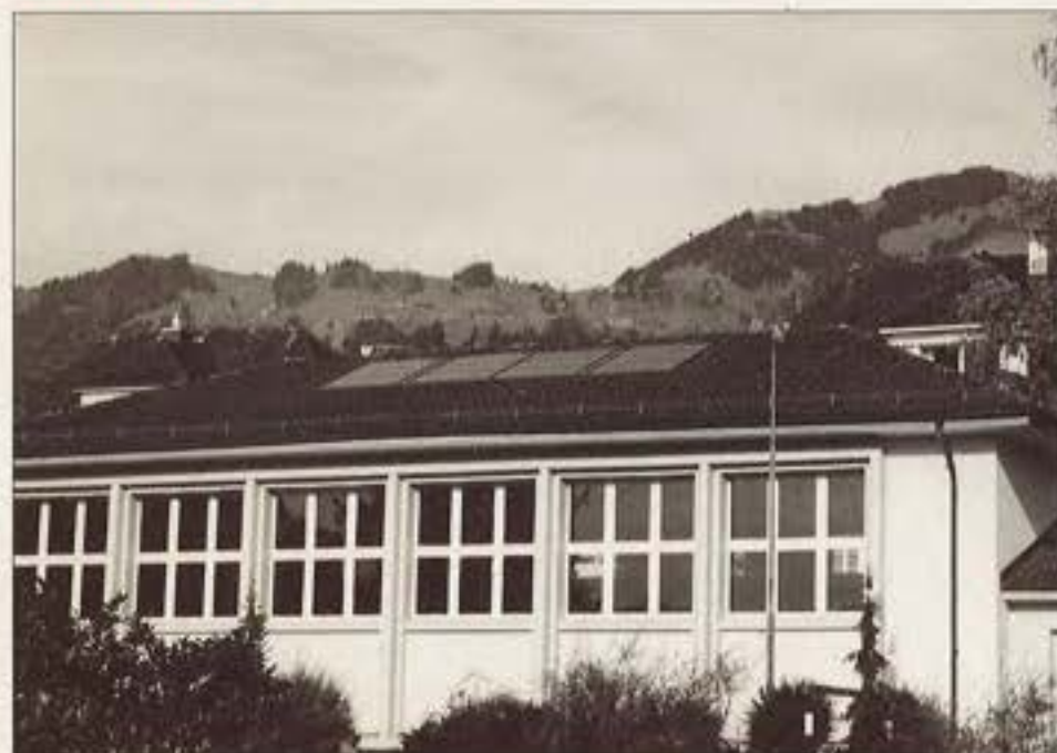
18 Quadratmeter gross ist die von acht Lehrern in einem Fortbildungskurs selbst gebaute Solaranlage auf dem Dach der Turnhalle des Schulhauses Lücken und spart jährlich 900 Liter Heizöl.
