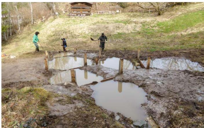
Die Stautafelgewässer im beinahe fertigem Zustand. Überschüssiges Wasser wird über die Einkerbung in der Holzwand abgeleitet.
