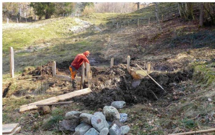
Der Einsatzleiter beim Einsetzen der stauenden Holzbretter im Gebiet «Rempen» eingangs Wägital.
