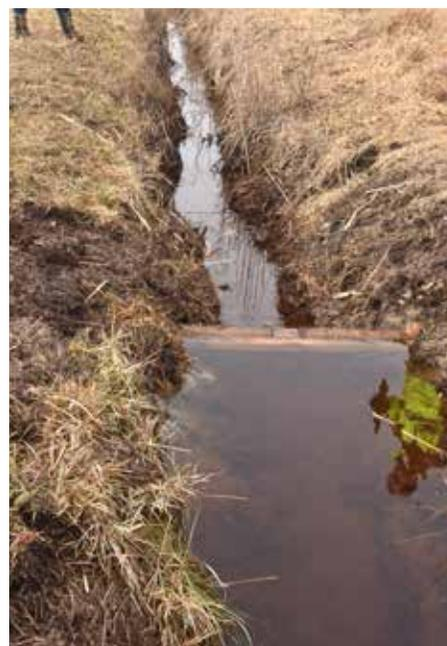
Durch die Stauung des Wassers mittels Spundwand kann der Moorboden viel Feuchtigkeit aufnehmen und zurückbehalten.
