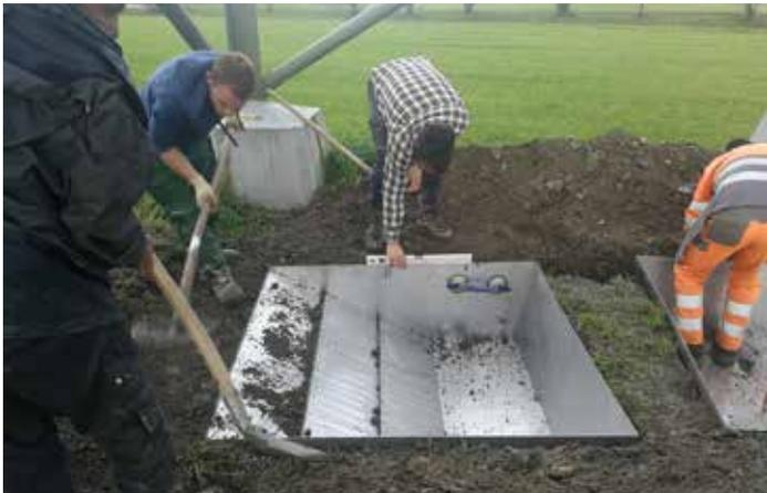
Die Stahlwannen sind leicht und können einfach von Hand eingesetzt werden.
