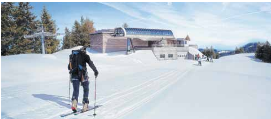
Bei der Bergstation Rotenflue ist ein Informationszentrum geplant.
