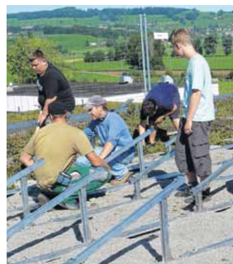
Gestellmontage auf dem Dach.
