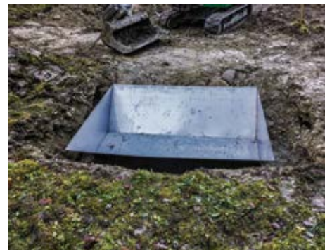
Beim Einbau der Stahlblechwannen für die Unken-Kleingewässer.
