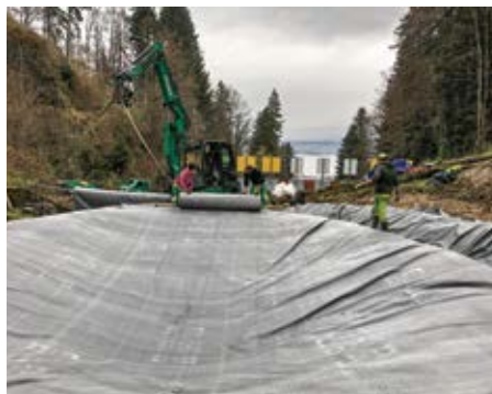
Verlegearbeiten der notwendigen Teichfolie. Die Folie besteht aus synthetischem Kautschuk (EPDM) und ist sehr langlebig.
