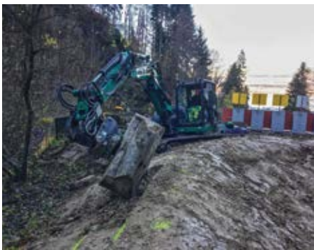
Die Bauarbeiten wurden durch die Firma Steiner Erdbau AG durchgeführt. Hier wird gerade sorgfältig der Einbindegraben für die Teichfolie gezogen.
