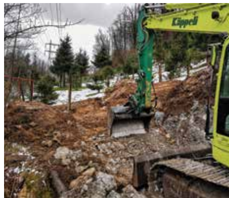
Baggerarbeiten für den neuen Bewirtschaftungsweg.
