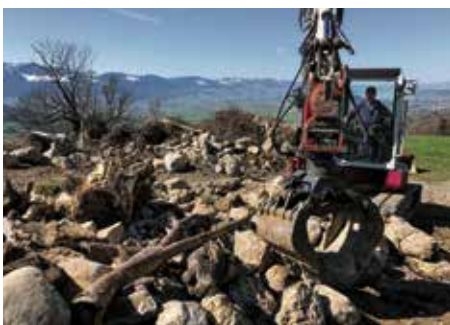
Die Bauarbeiten wurden durch Unternehmen «Steiner Hans Umgebungsarbeiten» sehr sorgfältig ausgeführt. Hier wird gerade die Holz-Stein-Linse erstellt.
