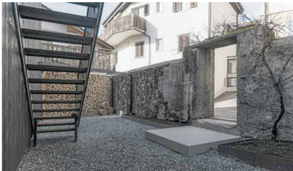
Modernste, ressourcenschonende Architektur trifft auf altherwürdige Mauern.
