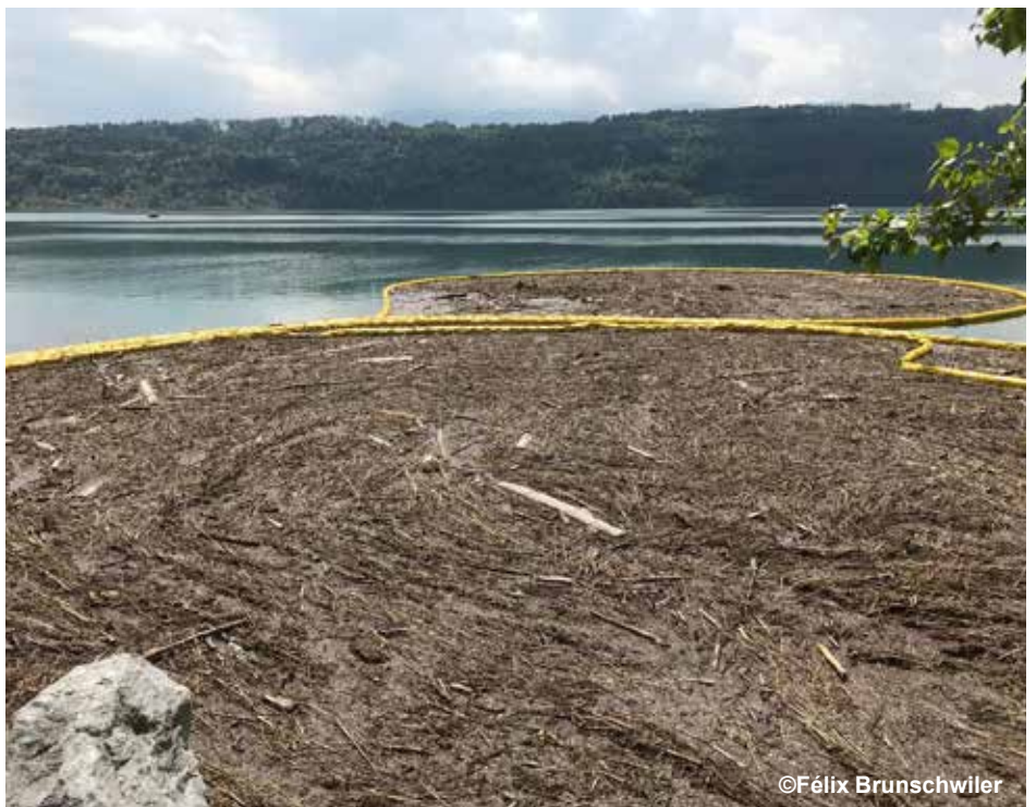
Die Schwemmholtzsperrre grenzt das Material ein und ermöglicht das Einziehen von Land oder vom Schiff aus.
