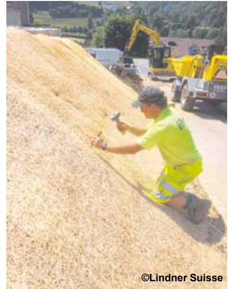
Holzwolle wird mit Holznägeln fixiert.
