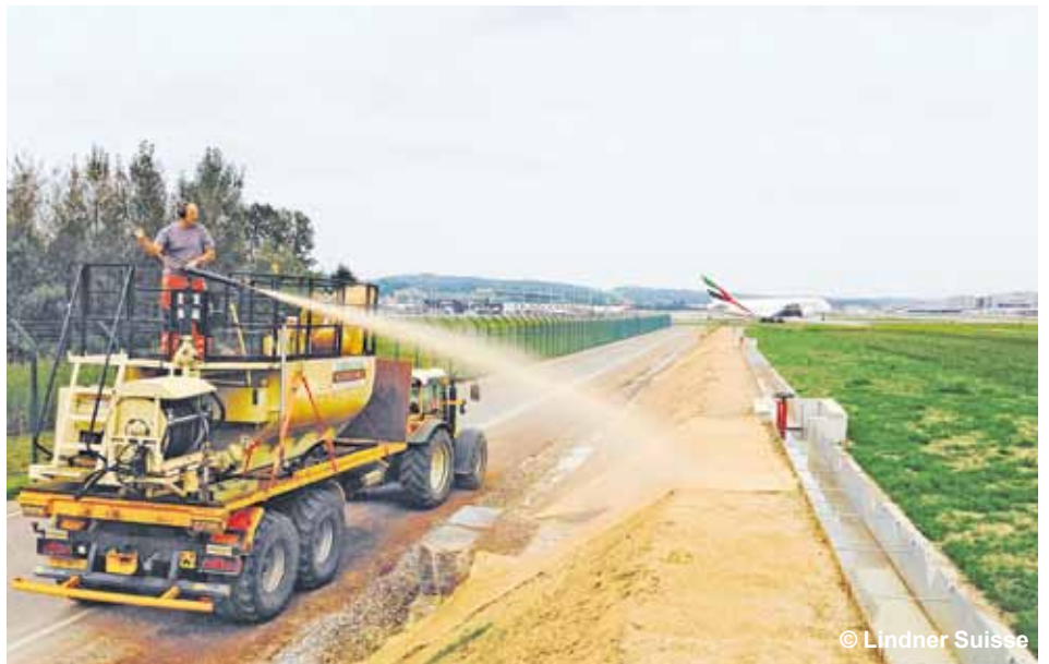
Die Holzwolle auf einer Böschung wird maschinell mit Hydrosaatgut bespritzt.
