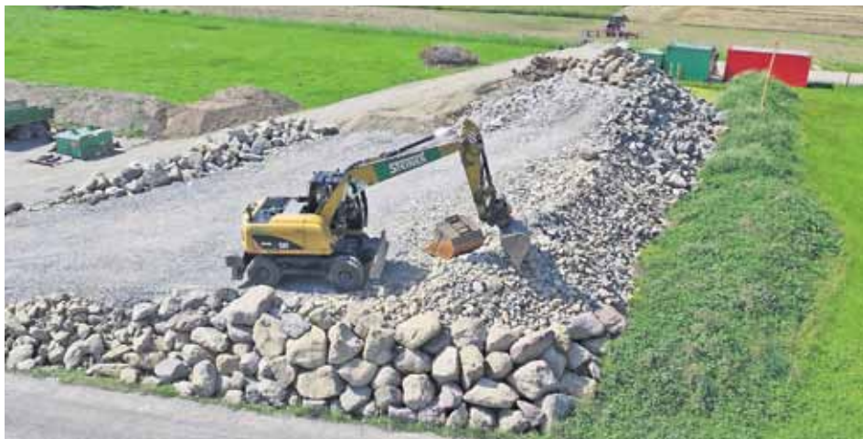
Seit ein paar Wochen liegt schon ein Teil der Steine für die Riffschüttung bereit.
