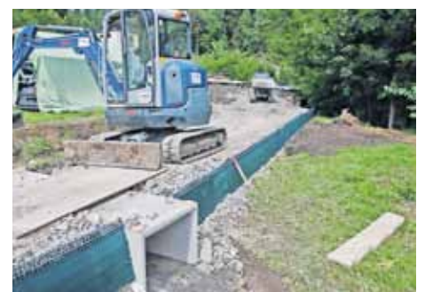
Amphibienleitwerk mit Unterführung.
