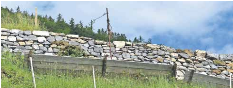
Eine zerfallene Trockensteinmauer wurde total zerlegt und wieder neu aufgebaut.
