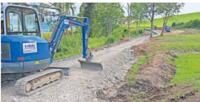
Sihlseewanderweg mit integriertem Amphibienleitwerk.
