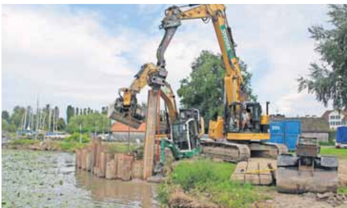
Mit Spundwänden wird die Baustelle trockengelegt.
