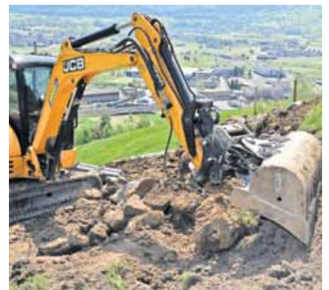
Eine sorgfältige Vorbereitung des Fundaments ist unerlässlich.
