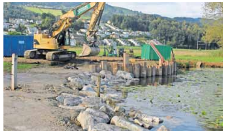
Vorne das totalsanierte Ufer, hinten ist die Sanierung im Gang.
